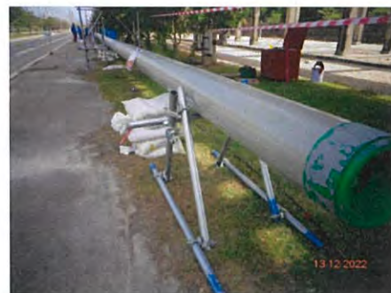
ภาพที่ 2-43 การป้องกันท่อส่งก๊าซฯ และระบบสาธารณูปโภค ข้างเคียงบนโครงสร้างชั้นวางท่อ (Pipe rack)
