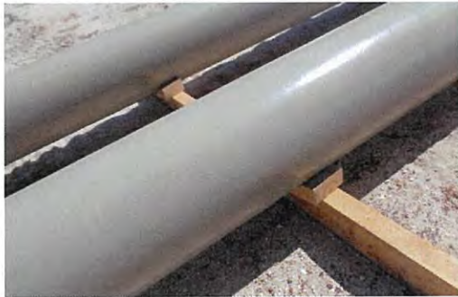
ภาพที่ 2-33 วัสดุที่ใช้ในการวางท่อบริเวณพื้นที่เก็บท่อ เพื่อป้องกันการพังทลาย อาทิ ไม้
