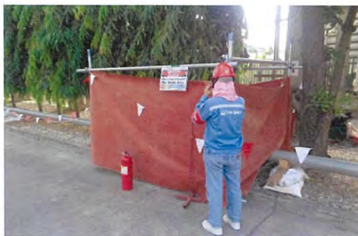
ภาพที่ 2-44 โครงสร้างเหล็ก (Pipe camp) ไม่กระดานปูพื้น ผ้ากันไฟ สำหรับการป้องกันสะเก็ดไฟและความร้อนจากงานเชื่อม
