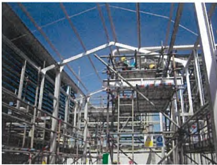
ภาพที่ 2-40 การติดตั้งนั่งร้าน
