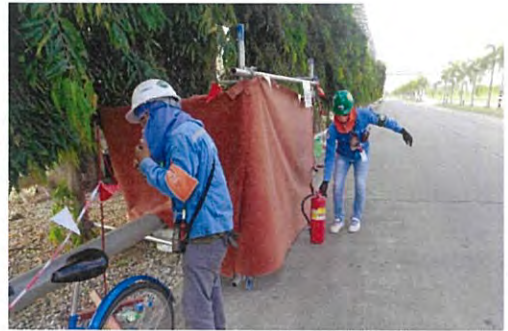
ภาพที่ 2-28 อุปกรณ์ดับเพลิงชนิดเคมีที่เคลื่อนย้ายได้ บริเวณพื้นที่ก่อสร้างที่อาจเกิดประกายไฟ
