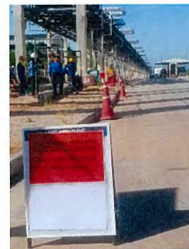
ภาพที่ 2-15 ป้ายแจ้งเตือนก่อสร้าง เครื่องหมายจราจร ป้ายเตือน ป้ายแนะนำ สัญญาณจราจรชั่วคราว บริเวณแนวท่อที่พาดผ่าน
