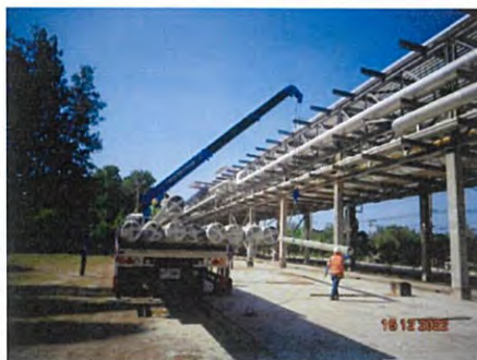
ภาพที่ 2-31 รถบรรทุกที่มีอุปกรณ์สำหรับการเคลื่อนย้ายท่อ
