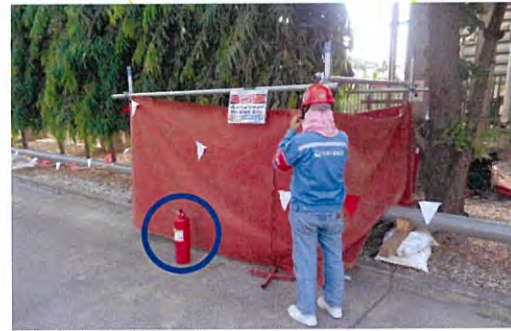
ภาพที่ 2-37 อุปกรณ์ฉุกเฉิน เช่น เครื่องดับเพลิงแบบผงเคมีแห้ง บริเวณพื้นที่กิจกรรมเชื่อมต่อท่อ
