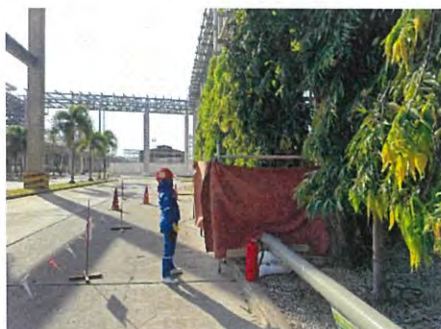
ภาพที่ 2-10 การกั้นเขตพื้นที่ก่อสร้างออกจากเส้นทางจราจร ให้เห็นชัดทั้งกลางวันและกลางคืน
